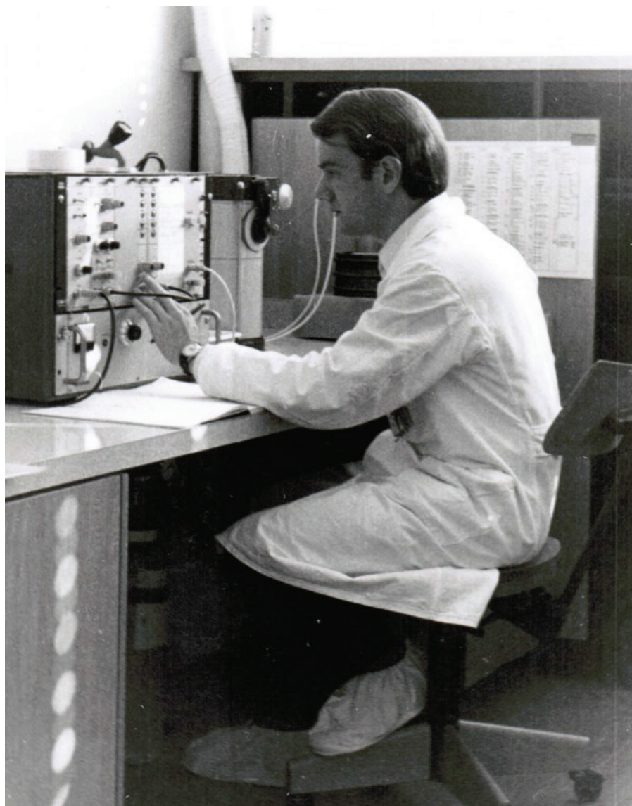
1972 Atomkraftwerk Beznau, Messung des Strontium 90 Isotopes im Primärkühlkreislauf.
